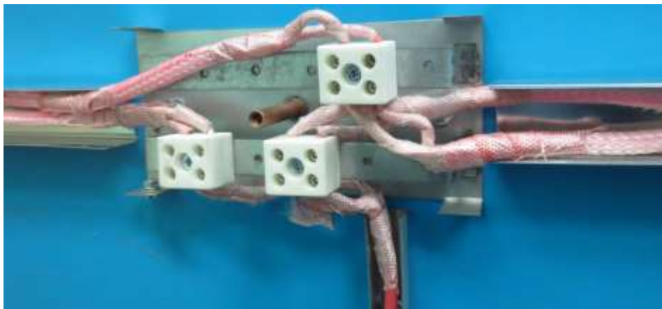
Рис. 24. Пример разделки и обработки кабеля в коробке КМ–О.
