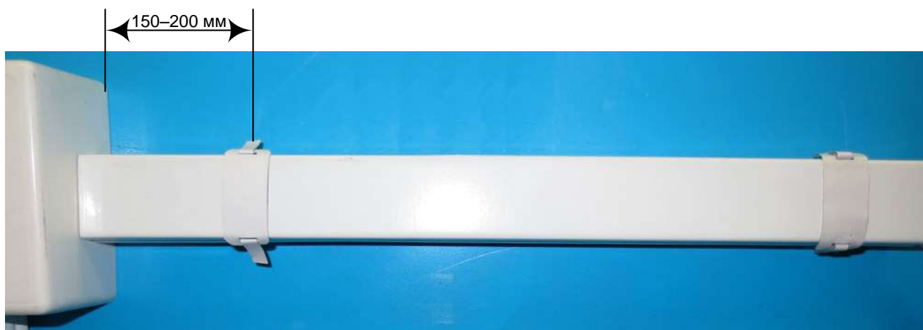
Рис. 19. Фиксация верхней крышки.
