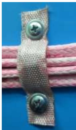
Рис. 6. Установка дюбель–хомута КФСТ.735322.041 и КФСТ.735322.164. Вариант 2.
